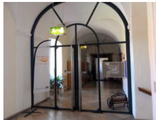
Tür vom Treppenhaus zu den Seminarräumen
