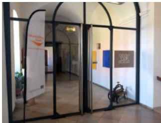
Tür vom Treppenhaus zu den Seminarräumen
