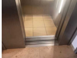
Aufzug im Klostergebäude
