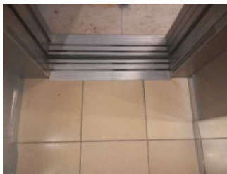
Aufzug im Klostergebäude
